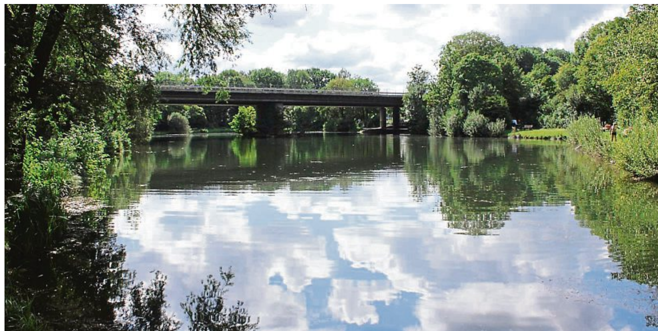
Idylle unter der Autobahn: Der erste Blick täuscht, derzeit gibt es hier viele Probleme.
